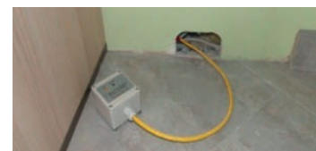
Feuchtesensor reagiert in Havariefällen, z.B. Rohrbruch o. Wasserüberlauf
