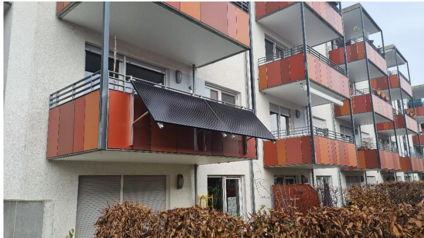
Abbildung 1: Schräg montierte PV-Module am Balkon an einem MFH in Heidelberg (Quelle: Baugenossenschaft Neu Heidelberg)
