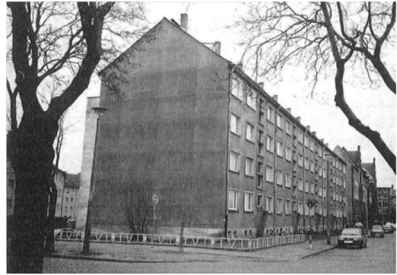
4 geschossig mit Satteldach
