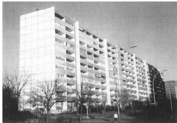
11 geschossig (P2/11) (Quelle: IEMB)
