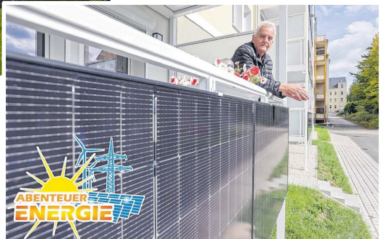
Uwe Gogol betreibt seit der Sanierung des SWG-Hauses an der Heinrich-Schütz-Straße sein eigenes Balkonkraftwerk.
